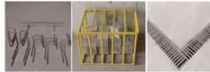
废钢筋进行广泛再利用:制作钢筋马凳、试块同条件养护笼、雨水篦子、灭火器及氧气乙炔笼、小洞口防护、模板内支撑导杆等。
